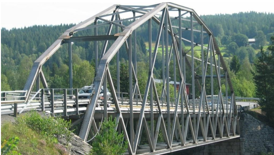
Fv. 40 Grettefoss bru. Dagens bru skal restaureres og bli en bru for gående og syklende. Foto: Buskerud fylkeskommune
